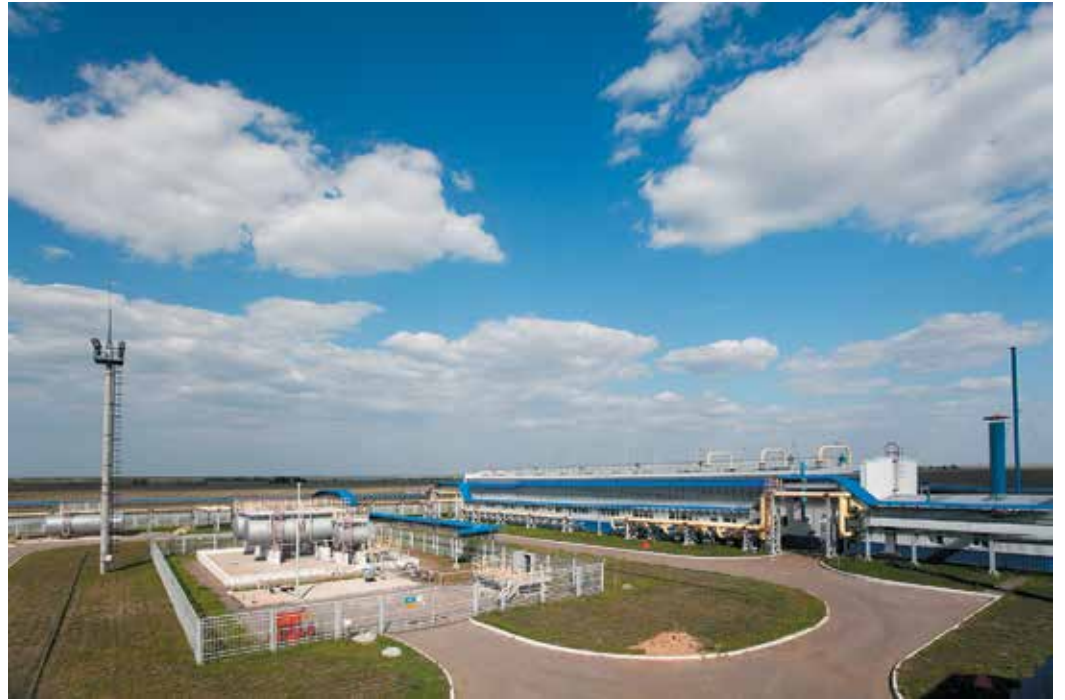
Реконструкция Степновской подземки — сегодня одна из приоритетных задач для «Газпром ПХГ»
