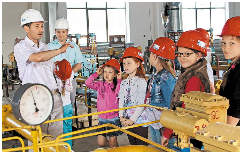
Заместитель главного инженера Калужского УПХГ Сергей Ченцов проводит экскурсию на объекте
