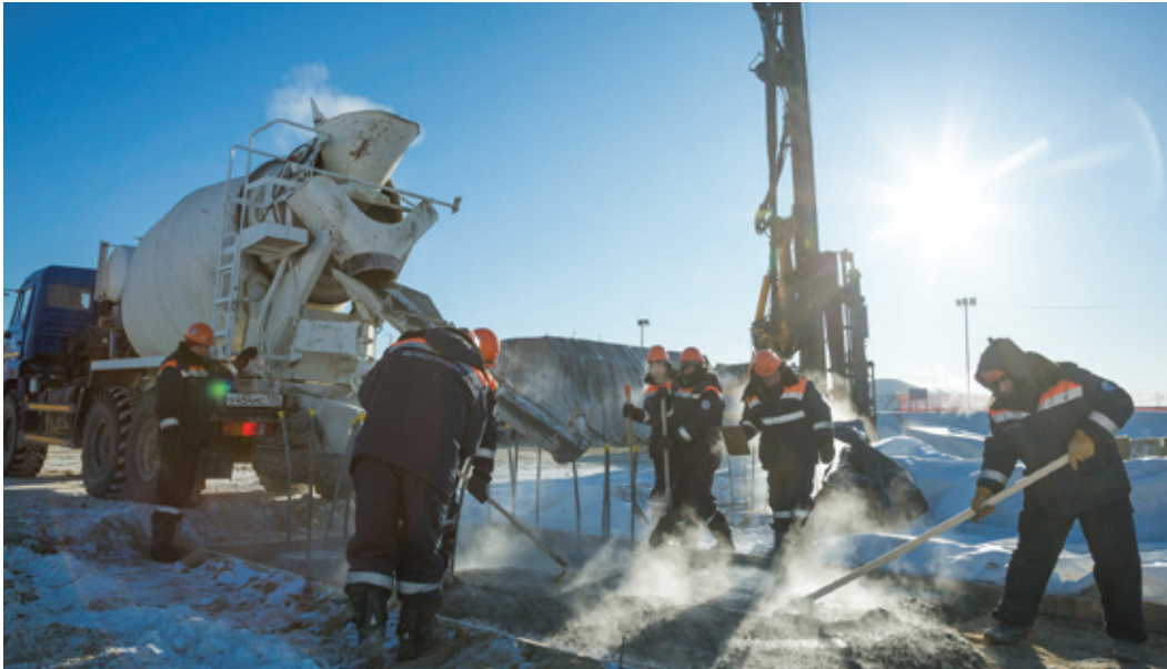
Строительство фундаментов под установки криогенного разделения газа
