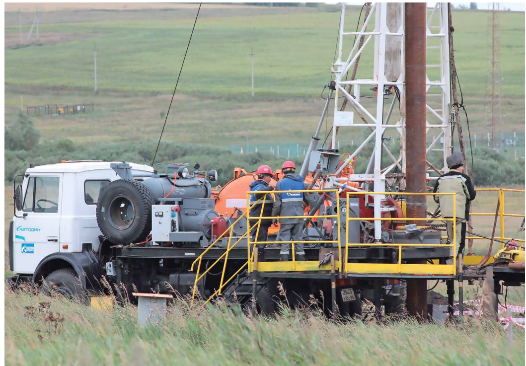
Плановые работы по ремонту средств электрохимической защиты
