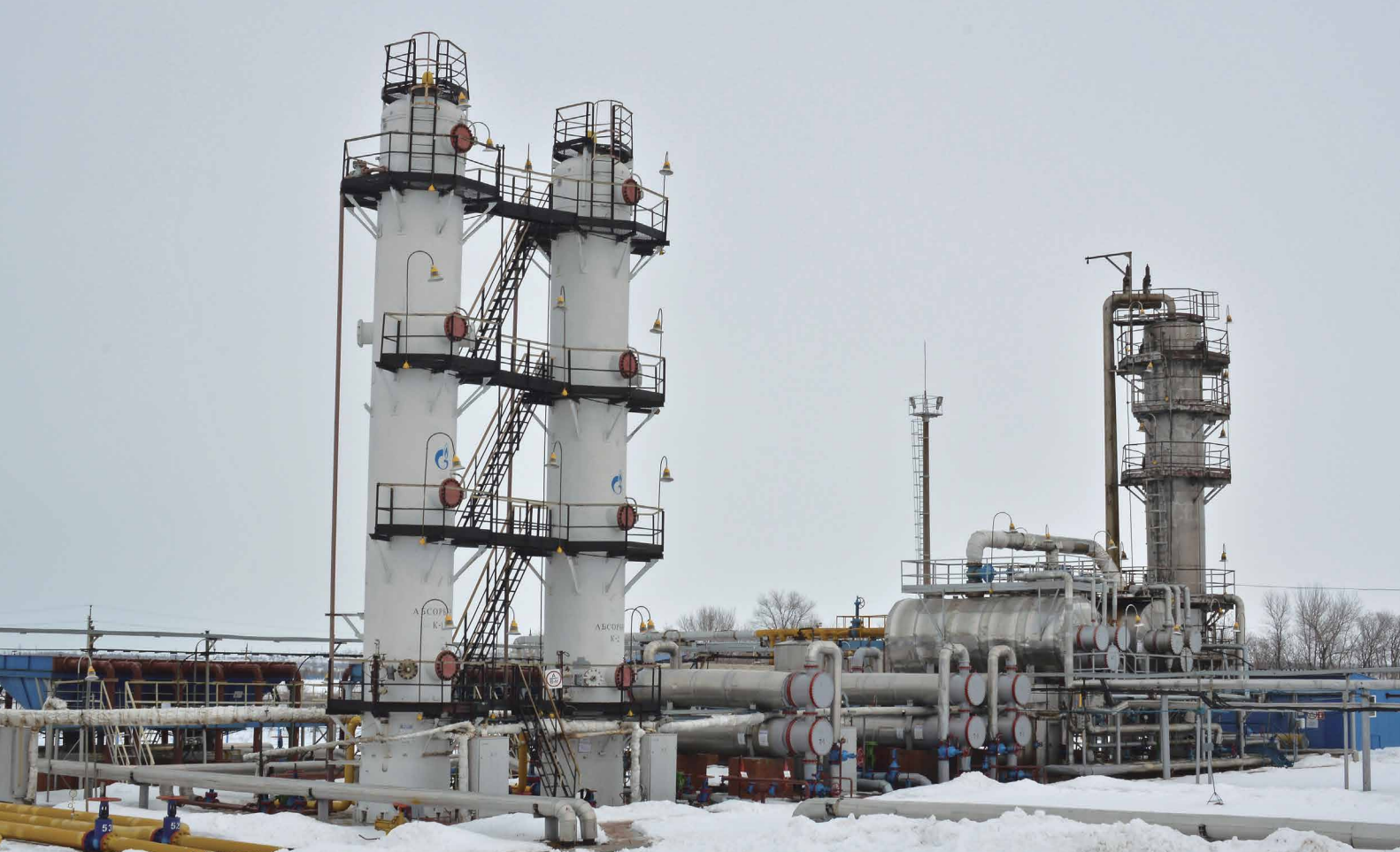
Январь 2020 года. УКПГ в ожидании начала реконструкции
