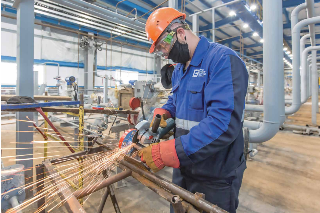
Процесс строительства сборного пункта газа № 1 Канчуринско-Мусинского комплекса ПХГ
