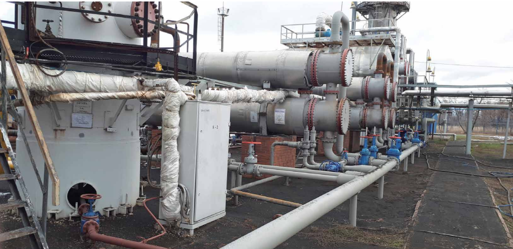
Комбинированная установка осушки и очистки газа от сероводорода Дмитриевского ПХГ в ноябре 2020 года. На объекте начинается этап изоляционных и покрасочных работ
