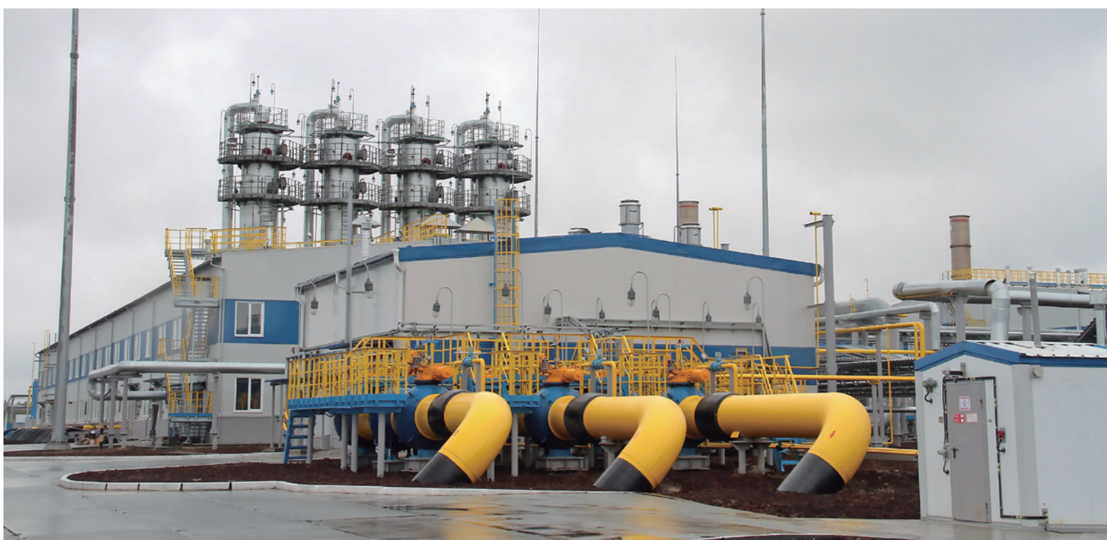
Новые объекты филиала «Пунгинское УПХГ» – узел замера и установка подготовки газа
