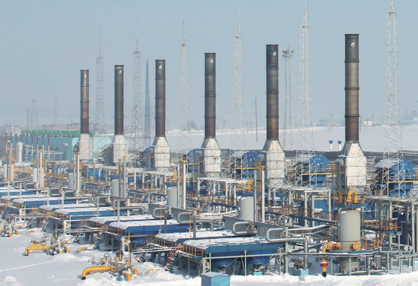
Агрегаты модели ГПА-10ПХГ-01 «Урал», работающие в филиале «Канчуринское УПХГ»
