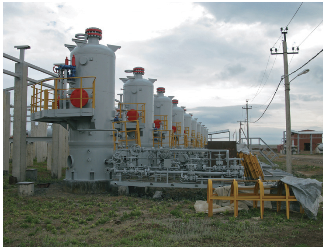
2010 год. Монтаж нового цеха осушки газа в филиале «Совхозное УПХГ»
