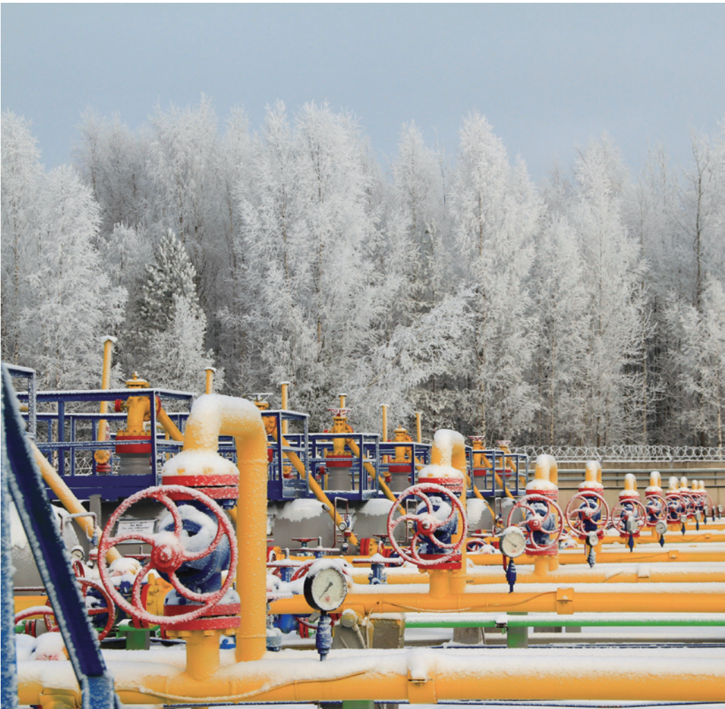
Первая ступень сепарации газа сборного пункта № 2 Невского УПХГ
