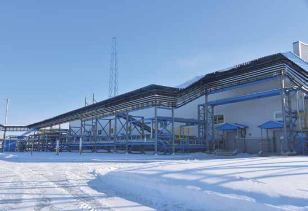
Здание ГРП-4 на территории Елшанского УПХГ
