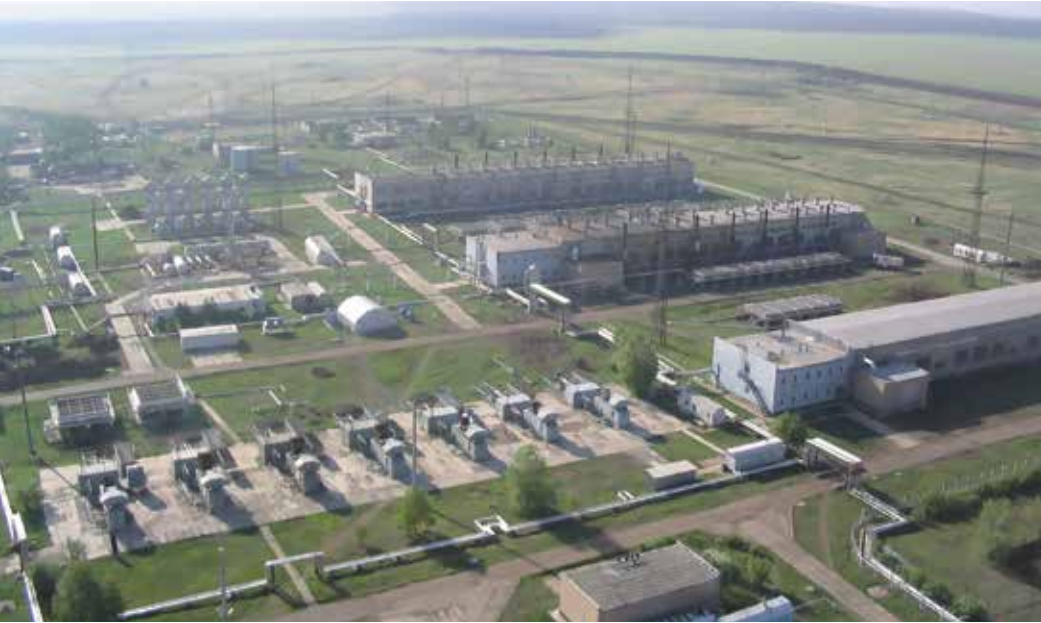
Середина 2000-х. Промплощадка Совхозного ПХГ до начала техперевооружения
